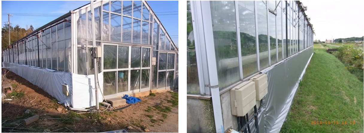
図 14 現地で導入された断熱強化の様子
