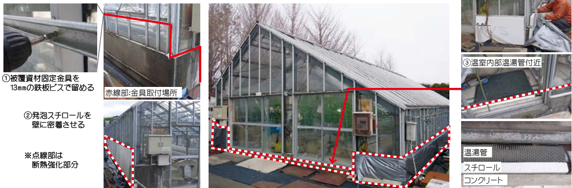
図13 スリークォーター型温室における断熱強化の施工工程（農林技術研究所の例）
