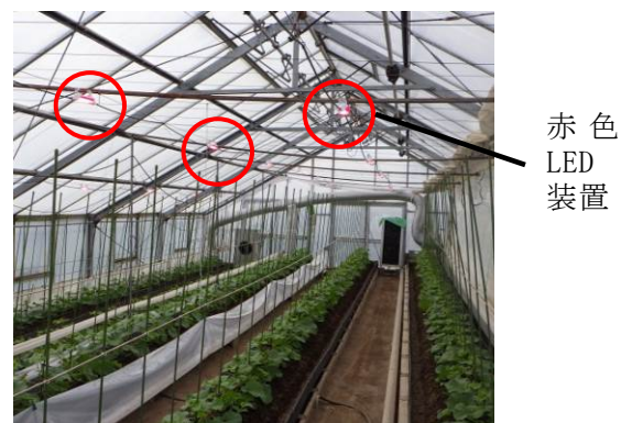
図 9 スリークォーター型温室における防除用赤色 LED 装置の設置事例
